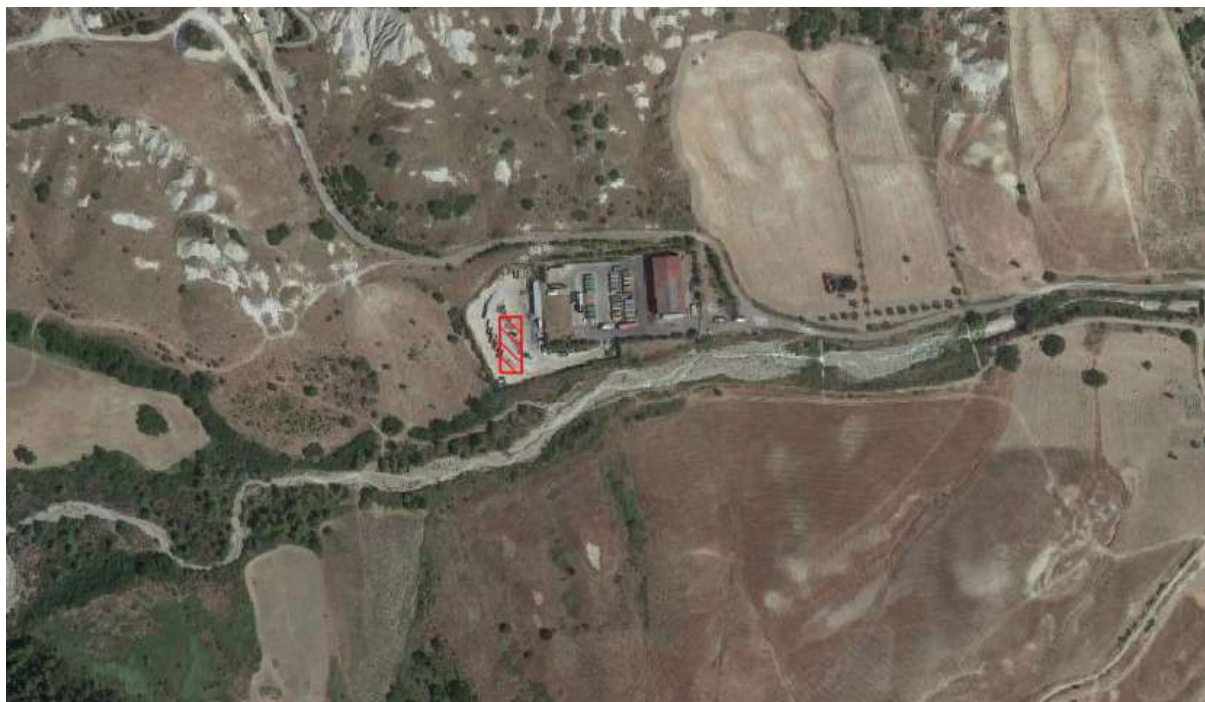
Figura 6 Posizione del nuovo biofiltro (in rosso)
